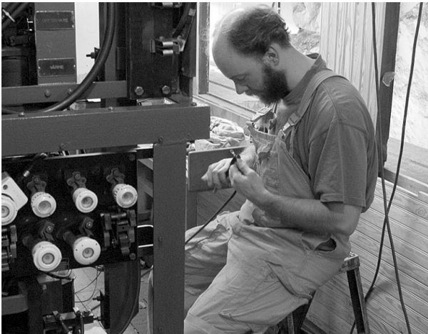
Calle Söderdahl monterar kabelmärkning till kontaktorstativet. Foto: Lasse Carlsson
